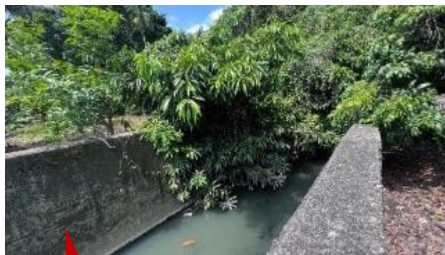
垂直水泥堤岸阻礙水陸域間的連通
